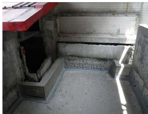
新設墩座及原防水層搭接
